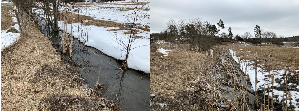
Figur 14 Dikena är rätade, djupt nedskurna med branta slänter och har en tydlig dikeskaraktär.
